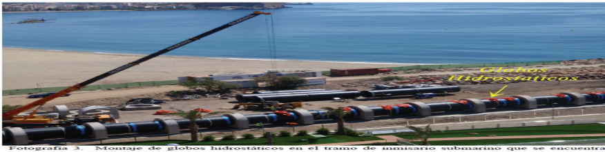
Fotografía 3. Montaje de globos hidrostáticos en el tramo de tubería submarino que se encuentra construido en la "lanzadera".
